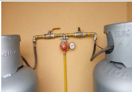
Foto 90 – Ligação dos cilindros de gás
