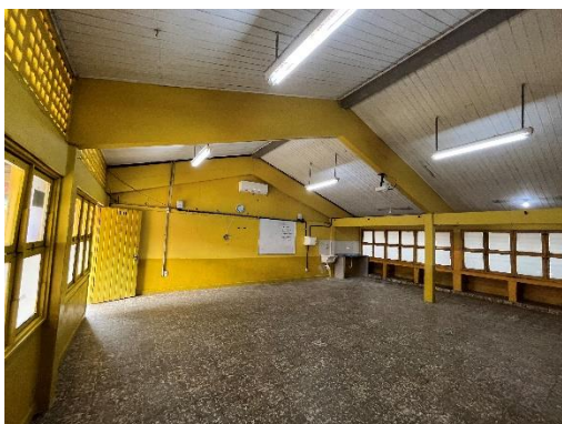
Foto 48 – Piso de ladrilho na sala de reuniões, com alto índice de desgaste
