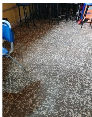
Foto 49 – Piso de ladrilho na sala de recursos, com alto índice de desgaste
